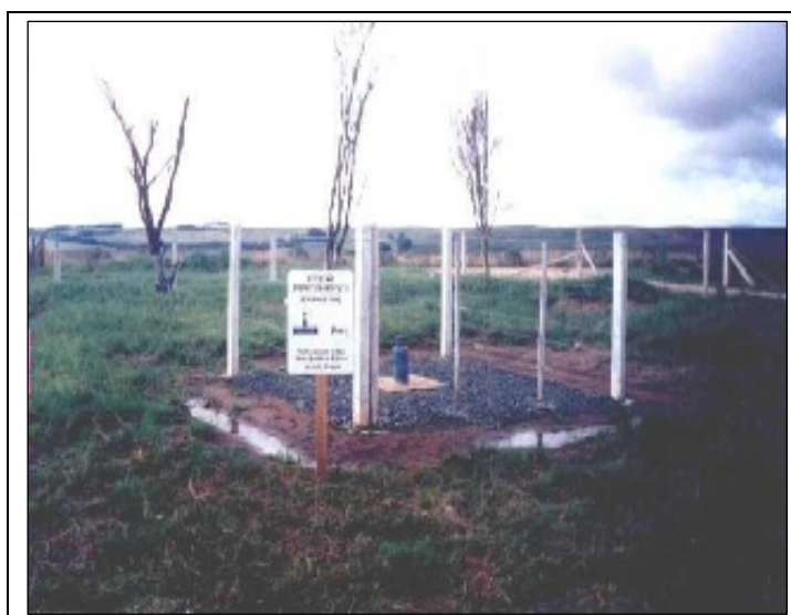
FIGURA 12: Aterro Controlado do Botuquara: poços de monitoramento construídos no local.
