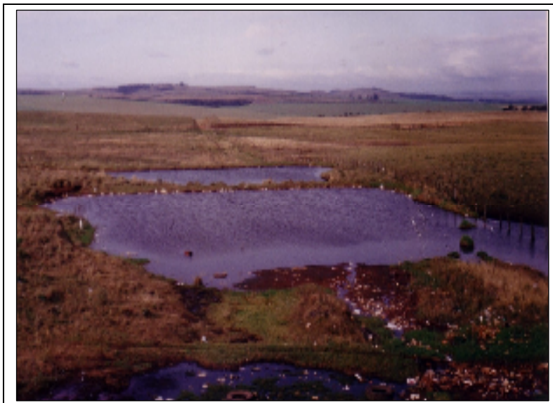
FIGURA 9: Lixão do Botuquara: lagoas de tratamento do lixiviado. Fonte: DEMARIO, 1992 102 .
