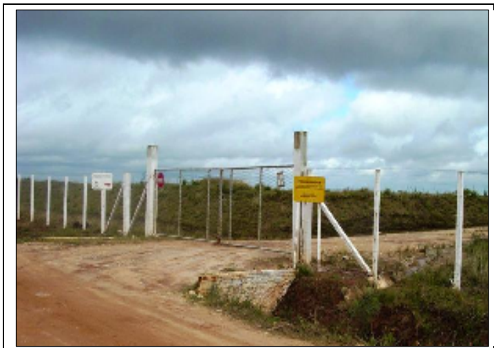
FIGURA 13: Aterro Controlado do Botuquara: portão para controle da entrada de pessoas. Fonte: Ponta Grossa Ambiental, período próximo a 2001.
