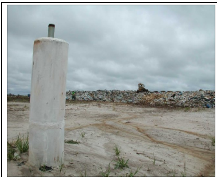
FIGURA 11: Aterro Controlado do Botuquara: Sistema de drenagem de emissões gasosas.
