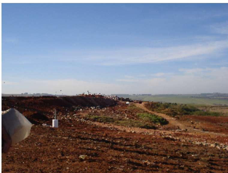
FIGURA 10: Aterro Controlado do Botuquara: vista do depósito de resíduos, agora com cobertura de argila. Fonte: autoria própria, 2007.
