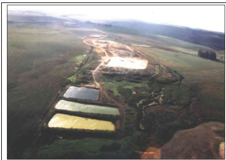
FIGURA 14: Aterro Controlado do Botuquara: lagoas de tratamento do lixiviado. Fonte: Ponta Grossa Ambiental, período próximo a 2001.
