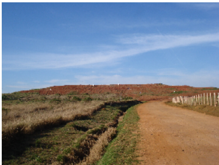
FIGURA 3: Aterro Controlado Botuquara. FONTE: autoria própria, período de 2007.
