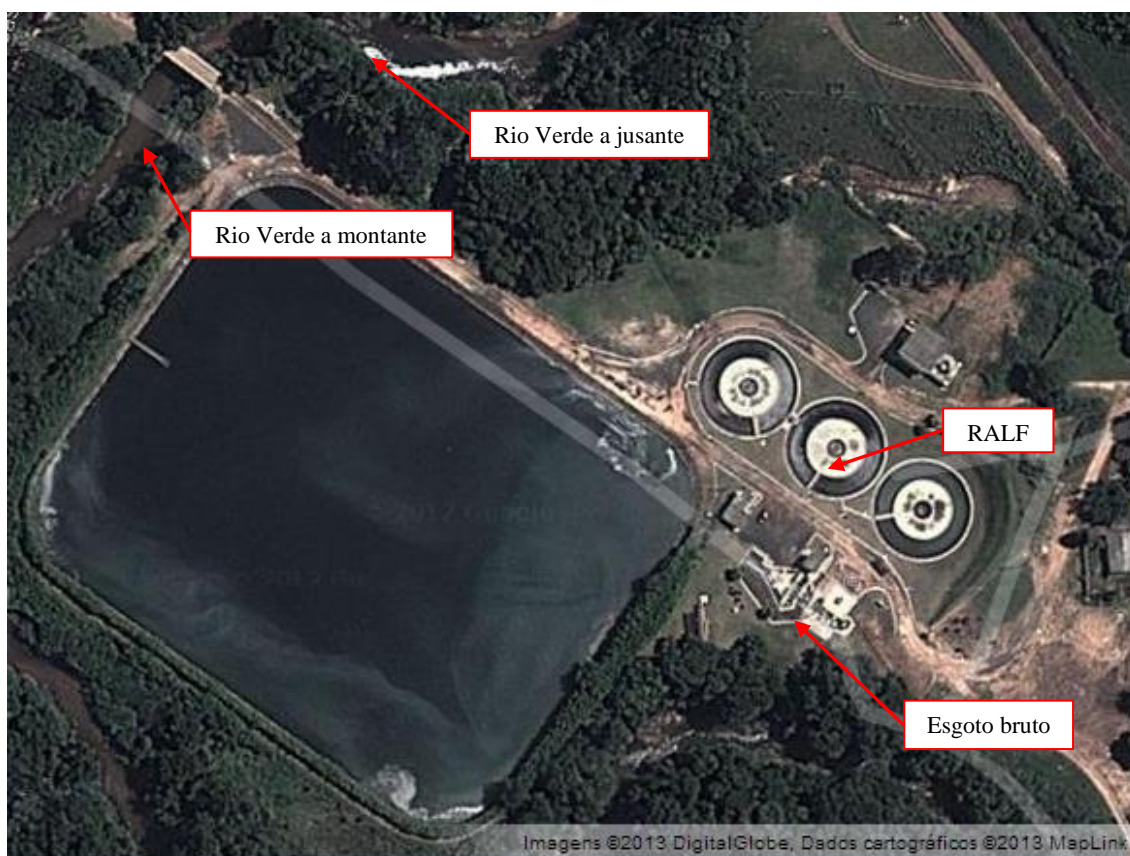
Figura 5 – Locais de coleta: águas superficiais no Rio Verde a montante e a jusante da ETE e efluente da ETE.
