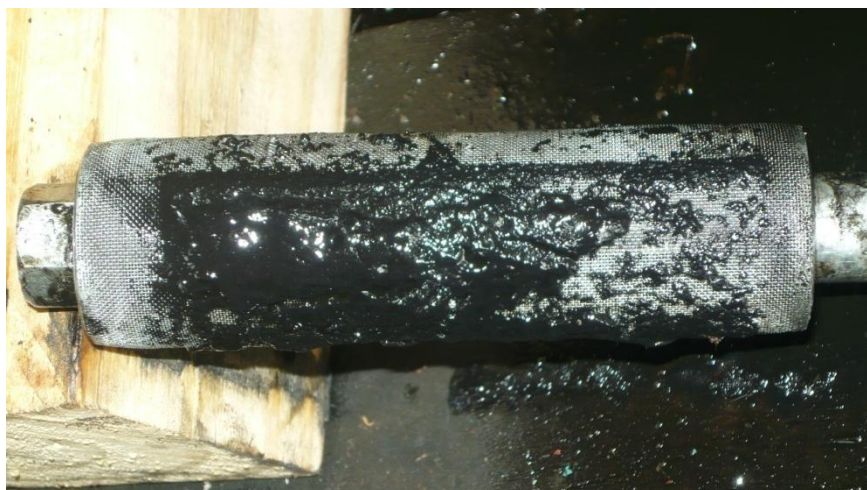
FIGURA 17. Borra de óleo lubrificante aderido na peneira da bomba de óleo no E-2
