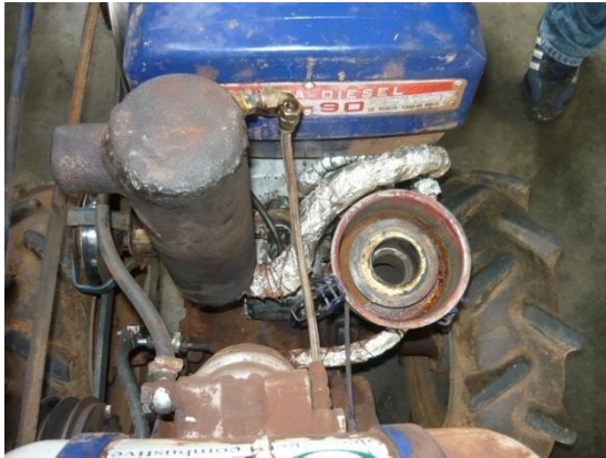
8a. Detalhe da linha do sistema de aquecimento do óleo vegetal combustível
