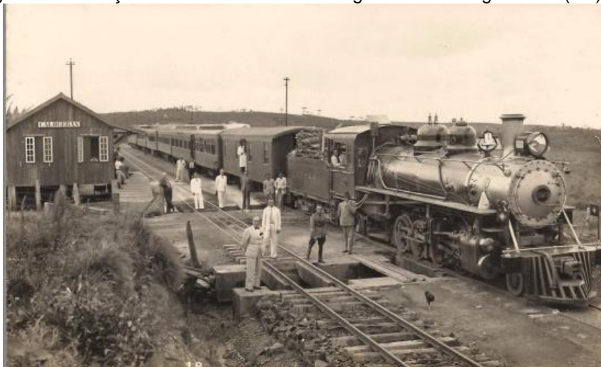
Fotografia 26: Estação ferroviária Jackson de Figueiredo em Jaguariaíva (PR), 1937
