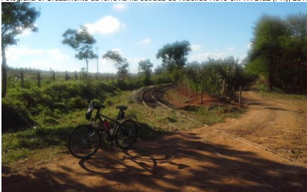
Fotografia 9: Cruzamento da ferrovia na estrada do Ribeirão Novo em W. Braz (PR), 2016
