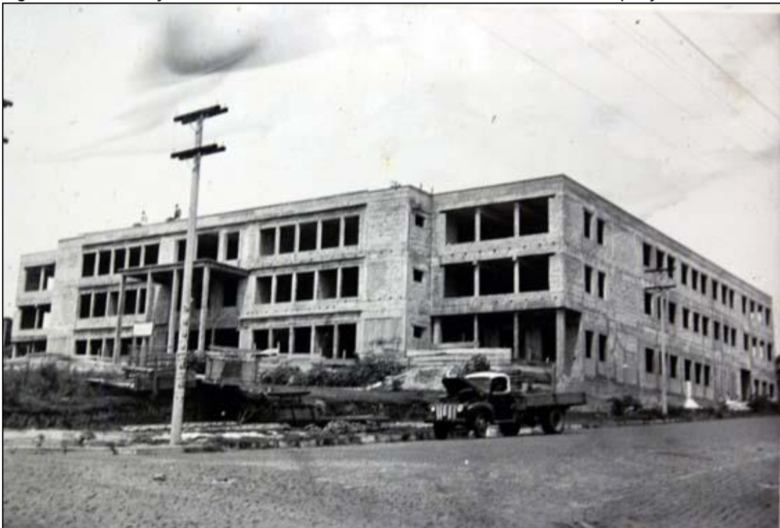
Figura 7 – Construção da Universidade Estadual de Ponta Grossa sobre a praça Santos Andrade, 1958
