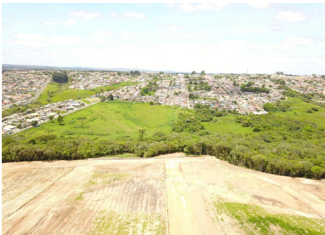
Fotografia 5 - Loteamento Ecopark Pilão de Pedra (vista da margem esquerda do arroio).
