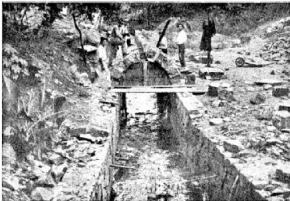
O serviço de canalização do arroio Pilão de Pedra, dentro do quadro urbano.
