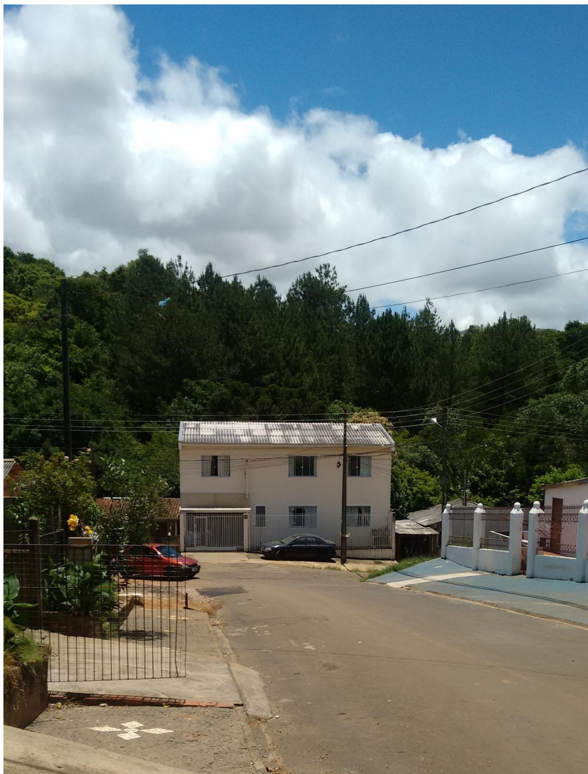
Fotografia 3 - Localização da antiga pedreira
