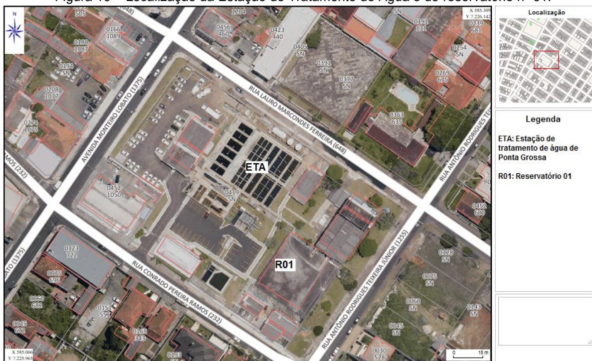
Figura 10 – Localização da Estação de Tratamento de Água e do reservatório nº 01.
