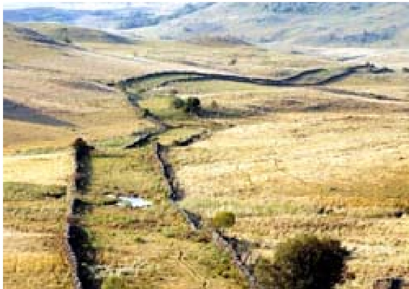
Figura 4 – Muro de taipa de pedra na região de Lages (SC) a Bom Jesus (RS) Fonte: Projeto (2005)
