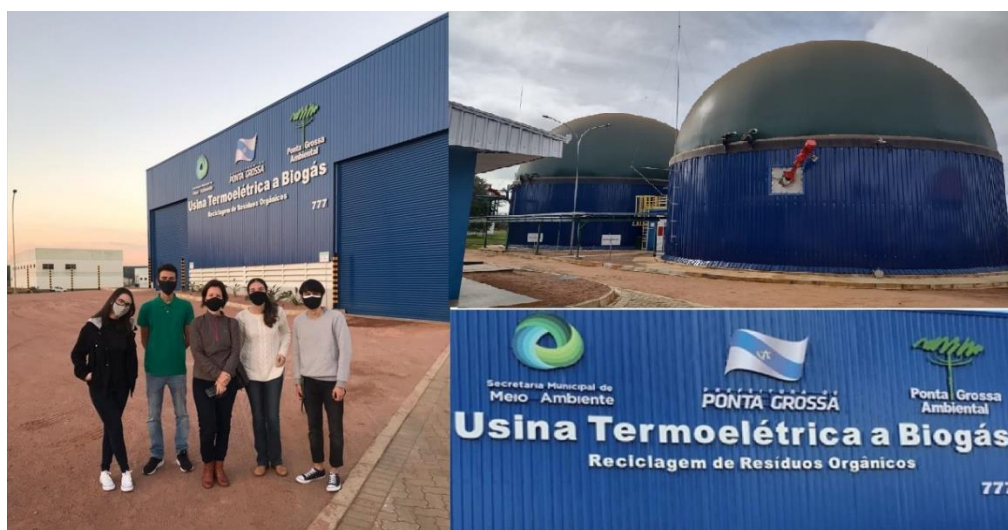
Figura 8 - Usina Termoeletrica a Biogás
