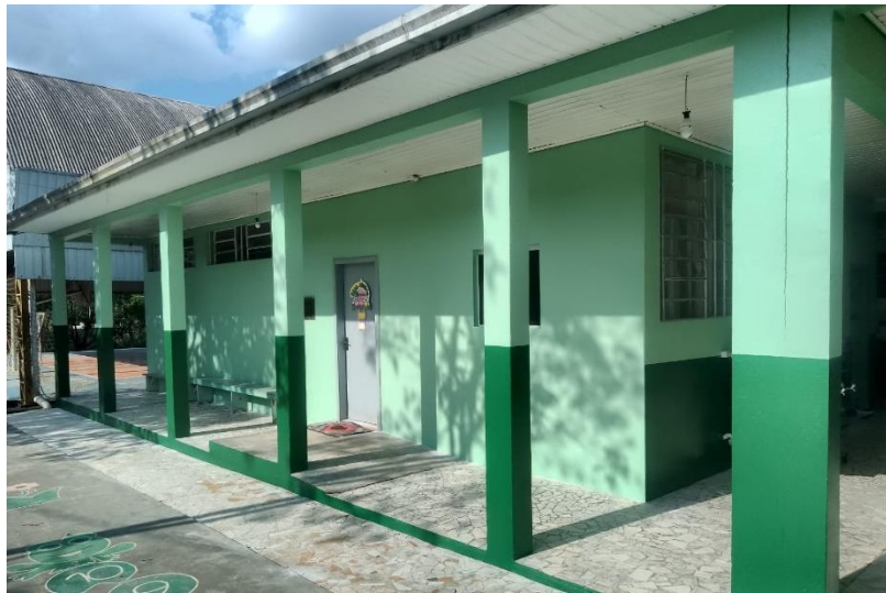
FIGURA 4 – Fachada e a frente da Escola de Avencal
