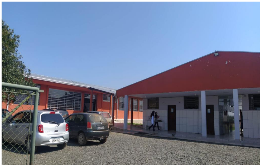
FIGURA 7 – Fachada da Escola de Lustosa
