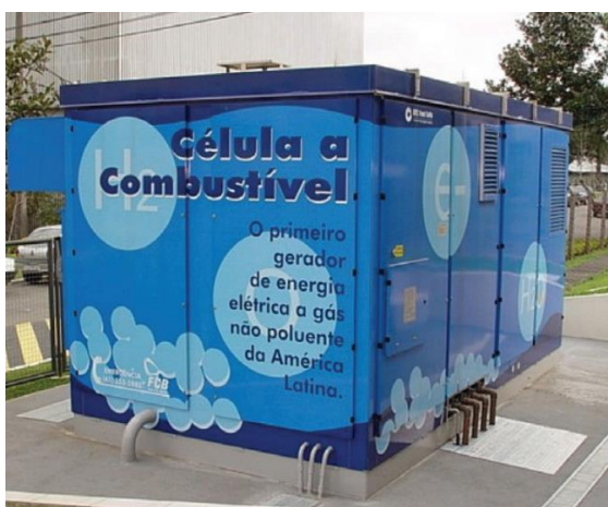
Figura 6 - Fotografia de Célula a Combustível de Ácido Fosfórico.
