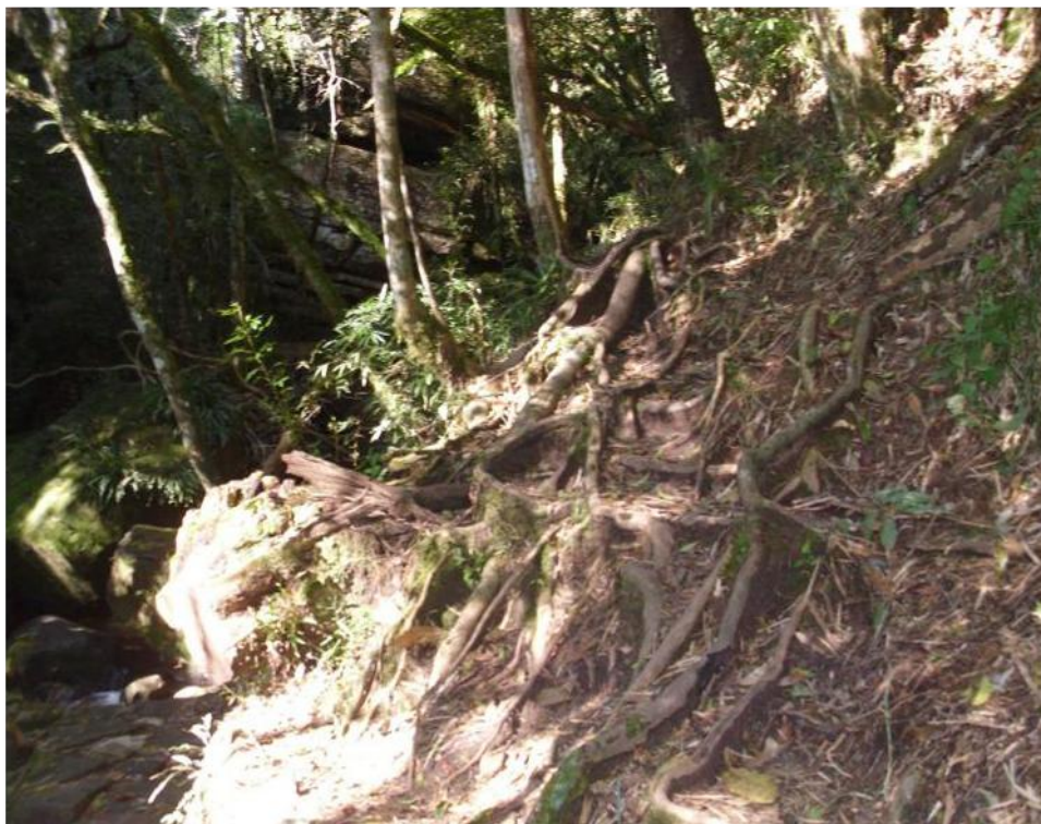
Figura 12 - Aspecto do segmento final da trilha, detalhe para as raízes expostas
