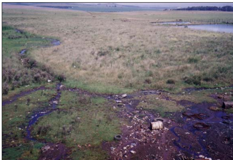
FIGURA 20: Foto Lixão Botuquara: chorume escorrendo da base do aterro. Ao fundo as lagoas de tratamento do lixiviado. Fonte: DEMARIO, 1992 77 .
