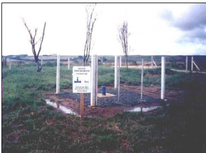
FIGURA 24: Foto Aterro Controlado do Botuquara: poços de monitoramento construídos no local. Fonte: Ponta Grossa Ambiental, período próximo a 2001.
