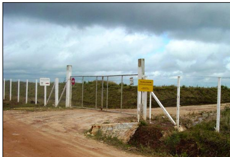
FIGURA 25: Foto Aterro Controlado do Botuquara: portão para controle da entrada de pessoas. Fonte: Ponta Grossa Ambiental, período próximo a 2001.
