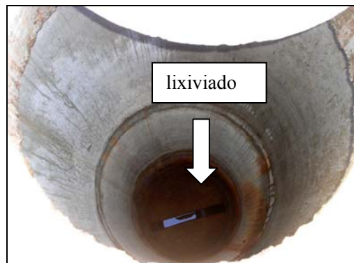
FIGURA 33: Visão interna de um dos poços de monitoramento. Ao fundo percebe-se o líquido lixiviado na calha do poço. Fonte: Autoria própria, 2007.
