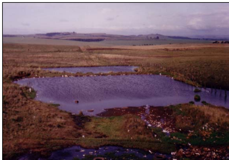
FIGURA 19: Foto Lixão do Botuquara: lagoas de tratamento do lixiviado. Fonte: DEMARIO, 1992 77 .
