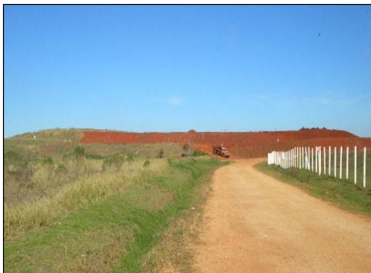
FIGURA 21: Foto Aterro Controlado do Botuquara: vista do morro de depósito de resíduos, agora com cobertura de argila. Fonte: autoria própria, 2006.
