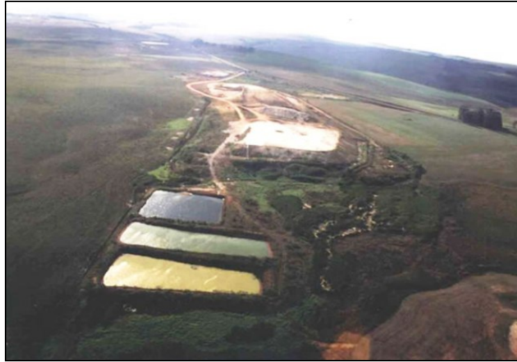
FIGURA 26: Foto Aterro Controlado do Botuquara: lagoas de tratamento do lixiviado. Fonte: Ponta Grossa Ambiental, período próximo a 2001.
