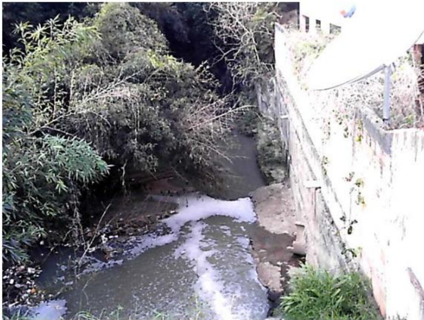
Figura 9- Residência situada na faixa de drenagem do Arroio Pilão de Pedra.
