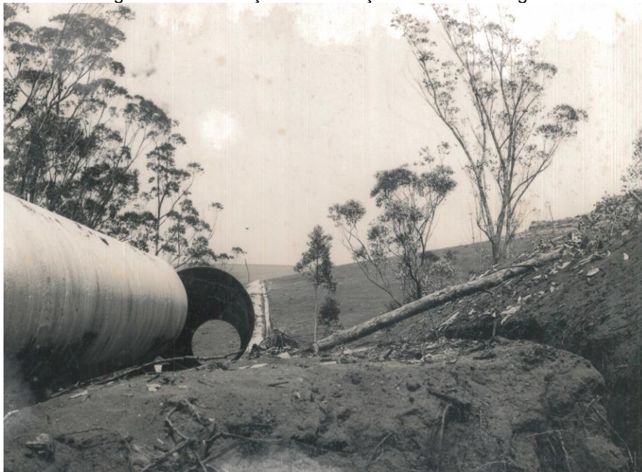
Figura 14: Construção da tubulação de coleta de água.
