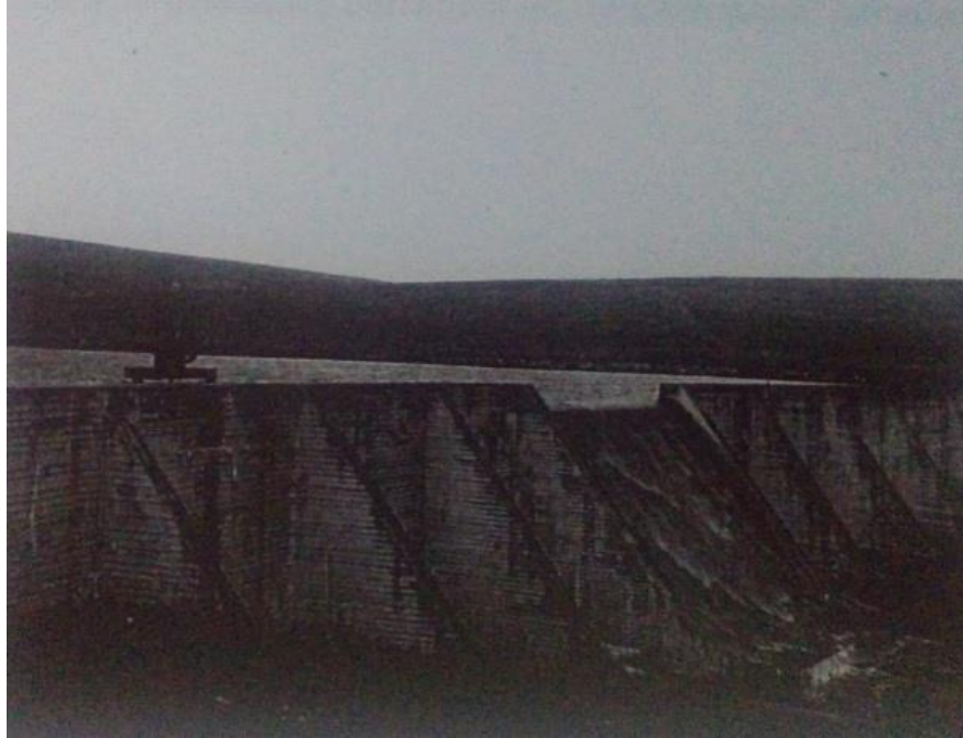
Figura 25: Barragem do Botuquara.
