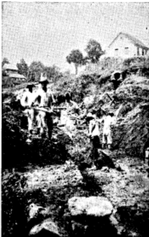
Canalização Rio Corrientes.
