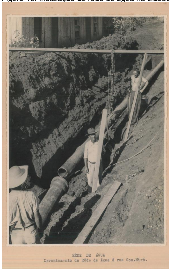
Figura 15: Instalação da rede de água na cidade.
