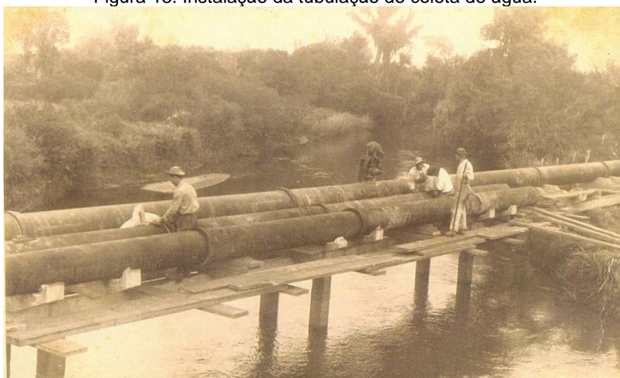
Figura 13: Instalação da tubulação de coleta de água.
