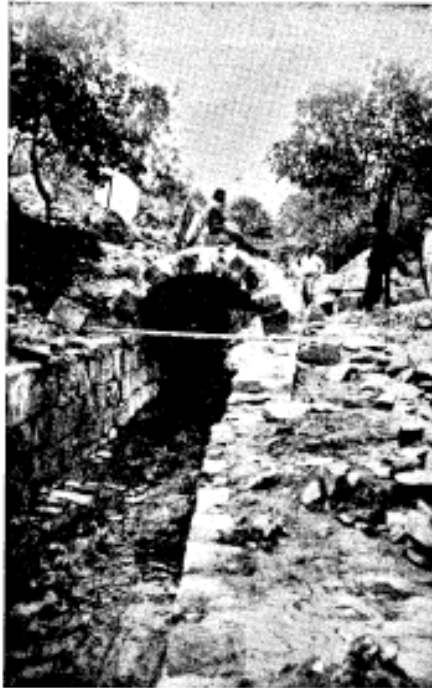
Canalização Rio Corrientes.
