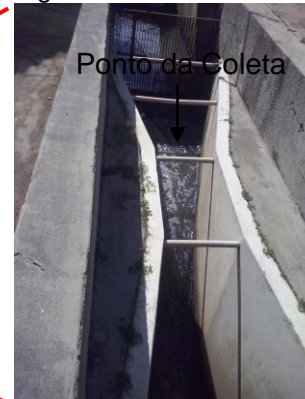
Figura 11. Calha Parshall.
