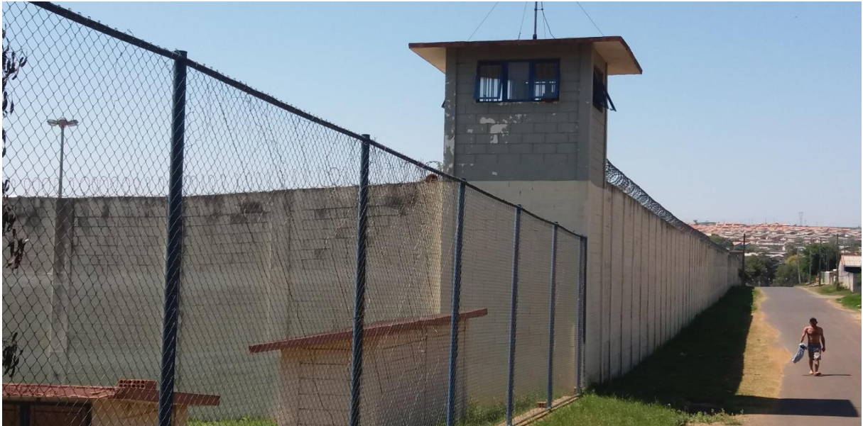
Figura 1 –Vista externa do Centro de Socioeducação de Ponta Grossa
