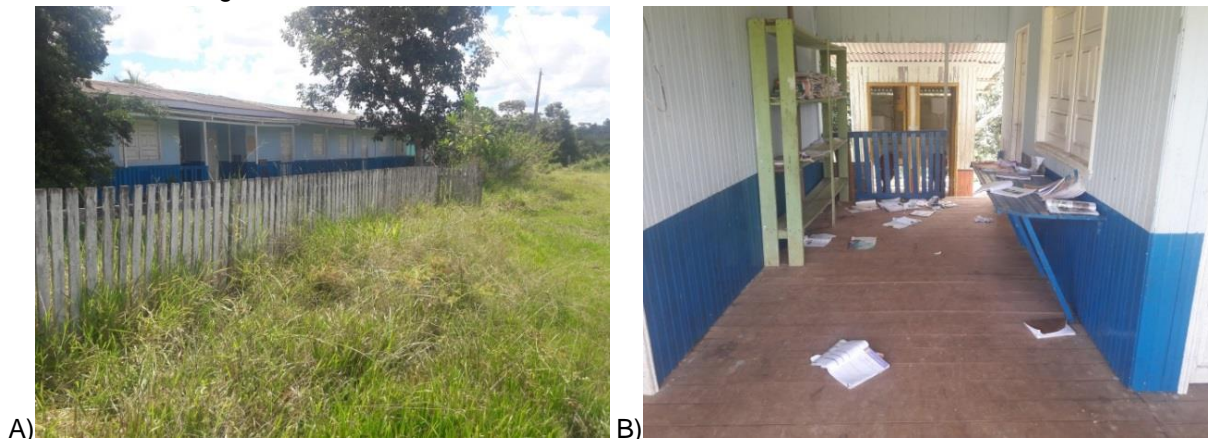
Figura 42 – Escola José Benício Moreira no interior do PAE Porto Rico
