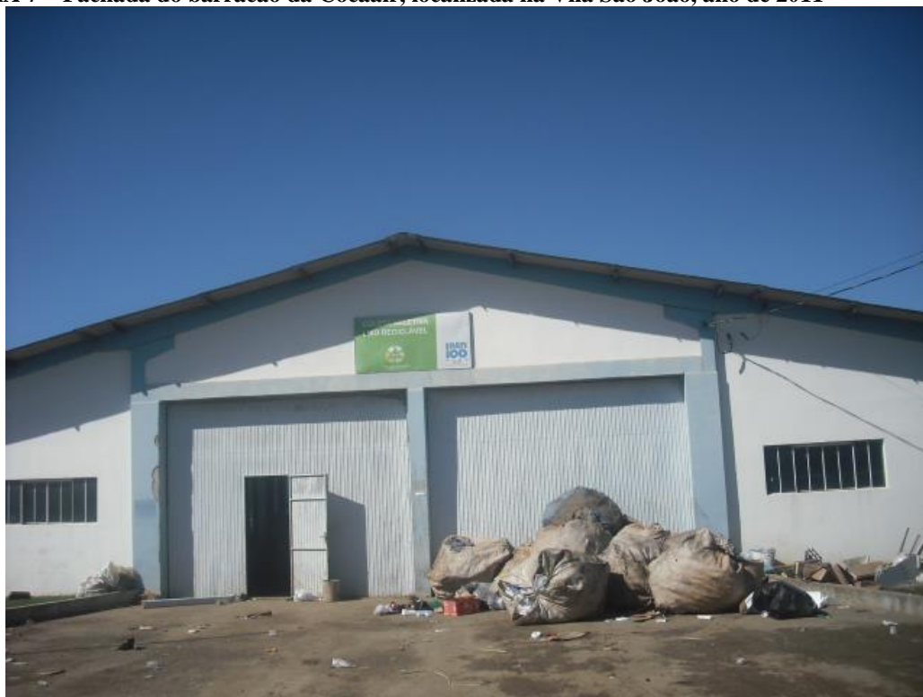
FIGURA 7 – Fachada do barracão da Cocaair, localizada na Vila São João, ano de 2011
