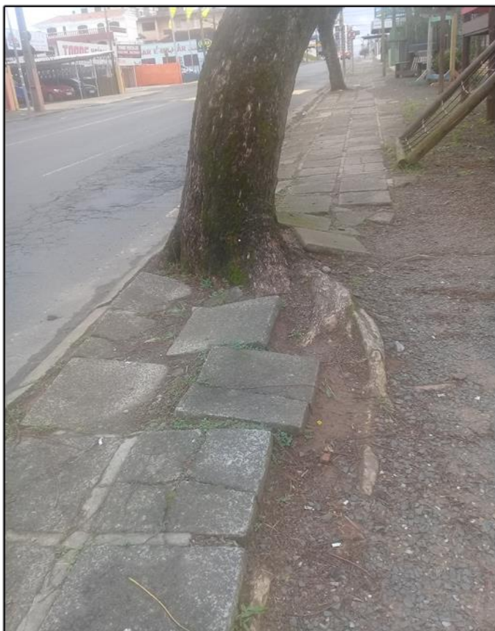
Figura 27 - Exemplo de conflito com a calçada na Avenida Monteiro Lobato, bairro Jardim Carvalho
