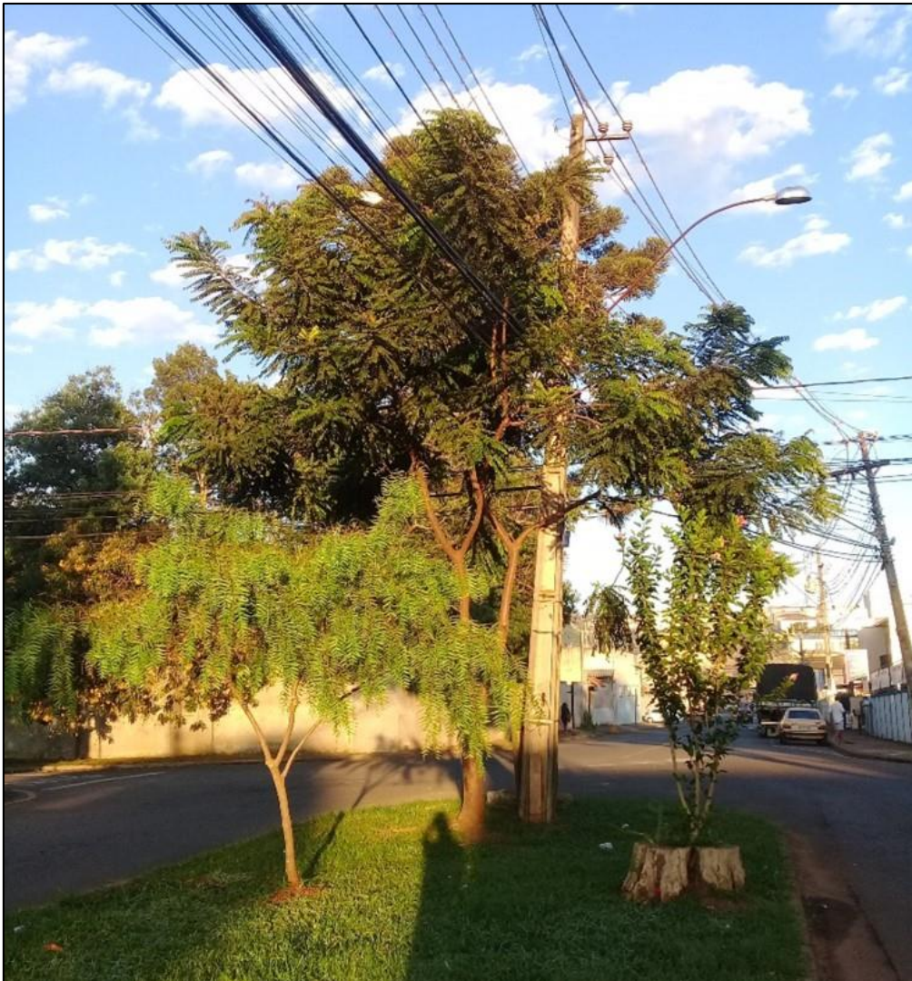
Figura 21 - Conflito com a fiação elétrica na Avenida Aldo Vergani, bairro Oficinas.
