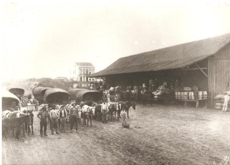
Figura 2 – Antigo barracão de cargas anexo à Estação, ano de 1906.
