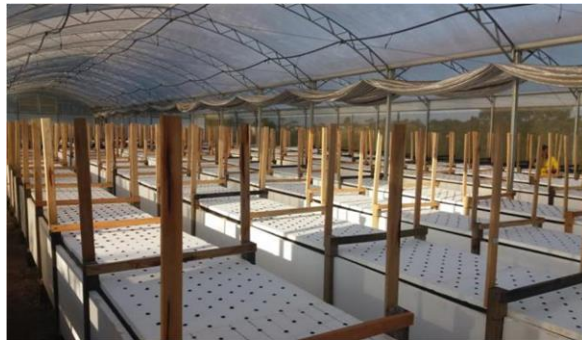
Bancadas construídas com madeira do sistema aeropônico. Fonte: A autora.
