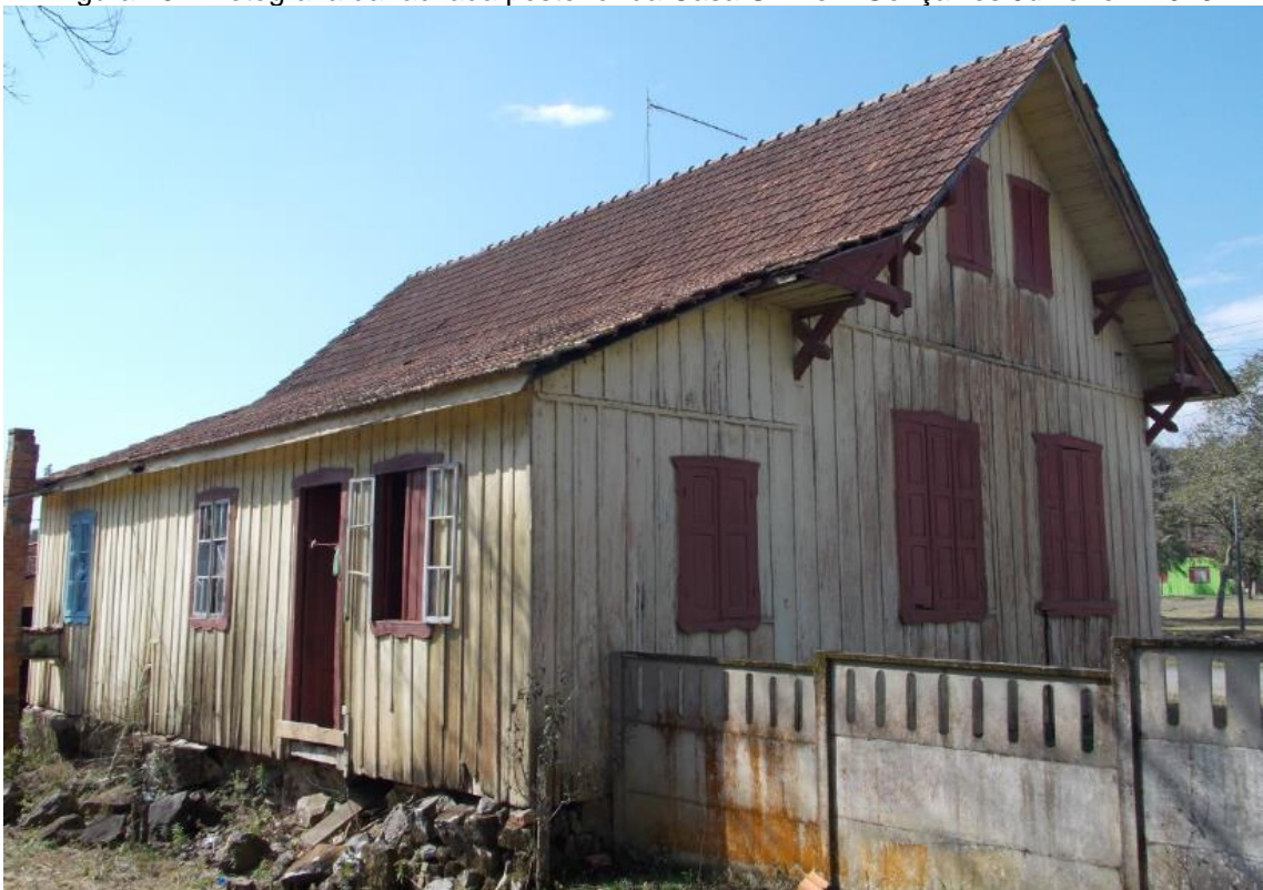
Figura 15 – Fotografia da fachada posterior da Casa Sink em Gonçalves Júnior em 2016
