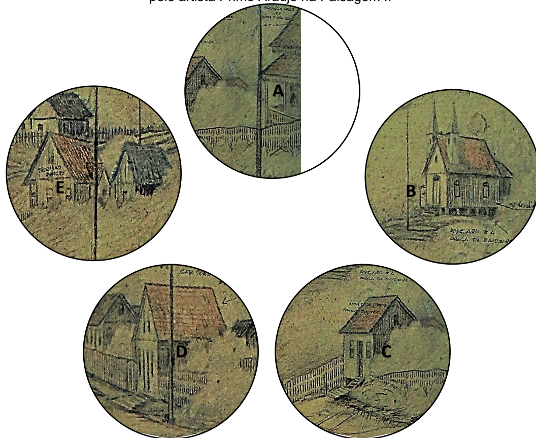
Figura 74 - Edificações de madeira dos primórdios de Irati retratadas pelo artista Primo Araújo na Paisagem II
