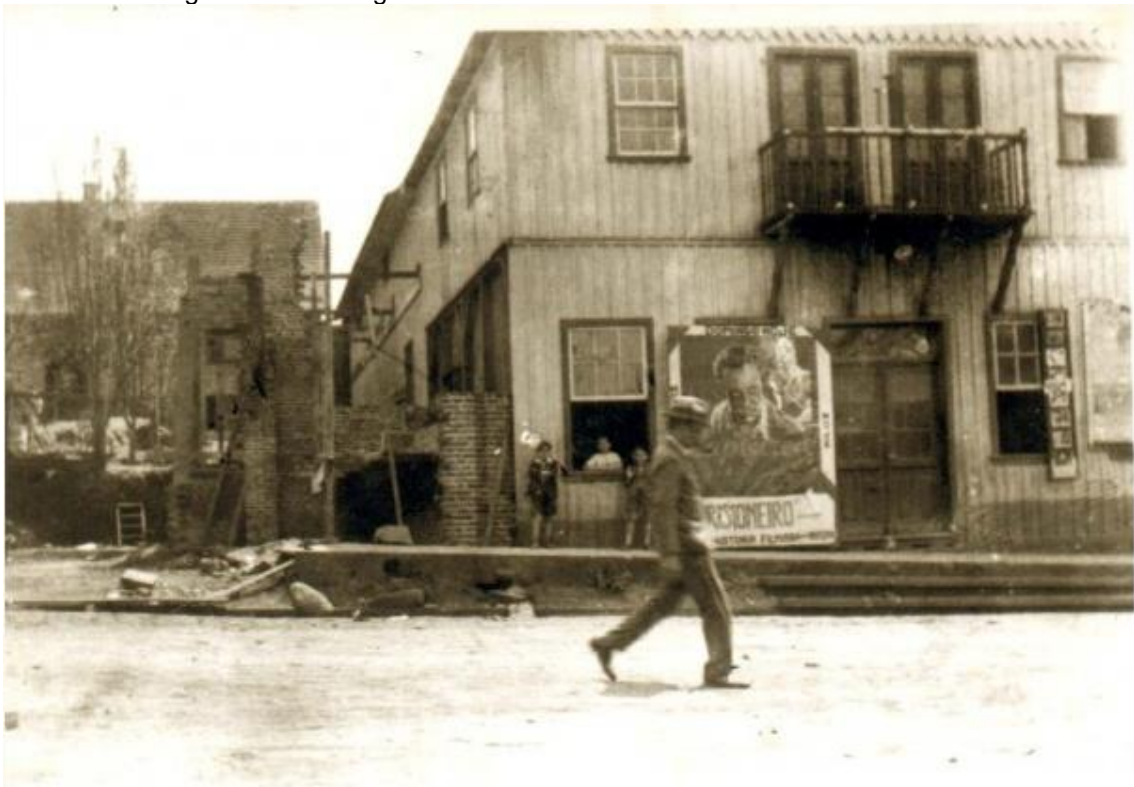
Figura 123 – Fotografia da reforma do Cine Theatro Central em 1936
