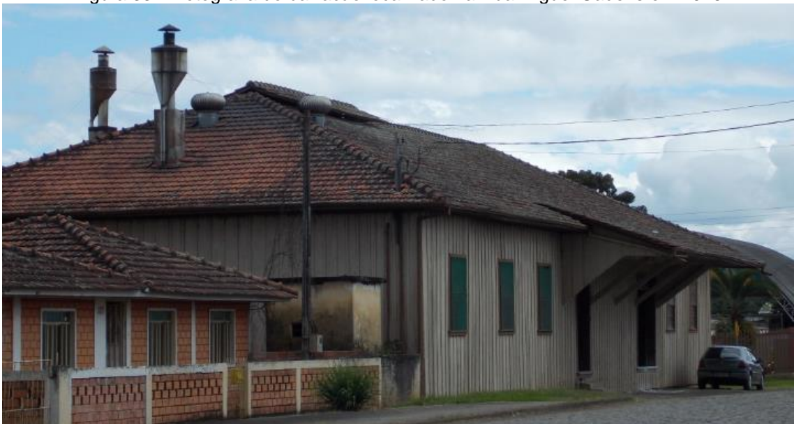
Figura 33 – Fotografia do barracão localizado na Rua Miguel Gadens em 2016
