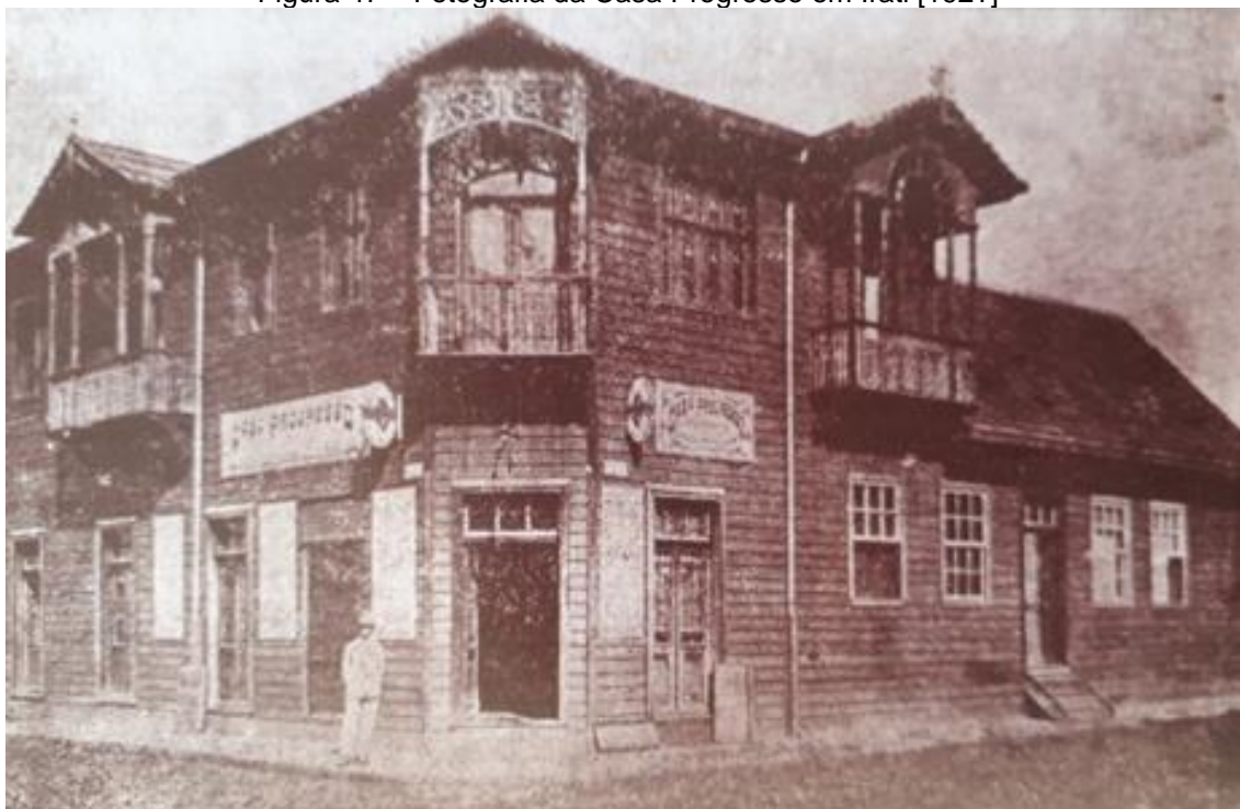
Figura 47 – Fotografia da Casa Progresso em Irati [192?]
