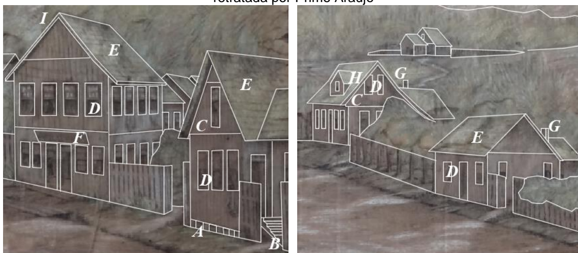
Figura 91 - Detalhes construtivos das edificações em madeira da Paisagem III retratada por Primo Araújo
