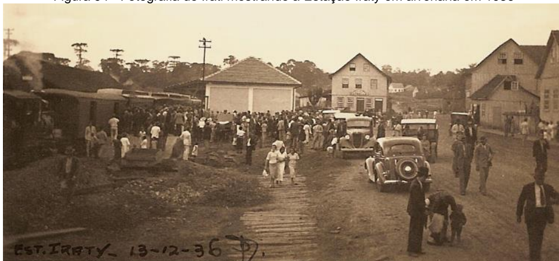
Figura 94 - Fotografia de Irati mostrando a Estação Iraty em alvenaria em 1936
