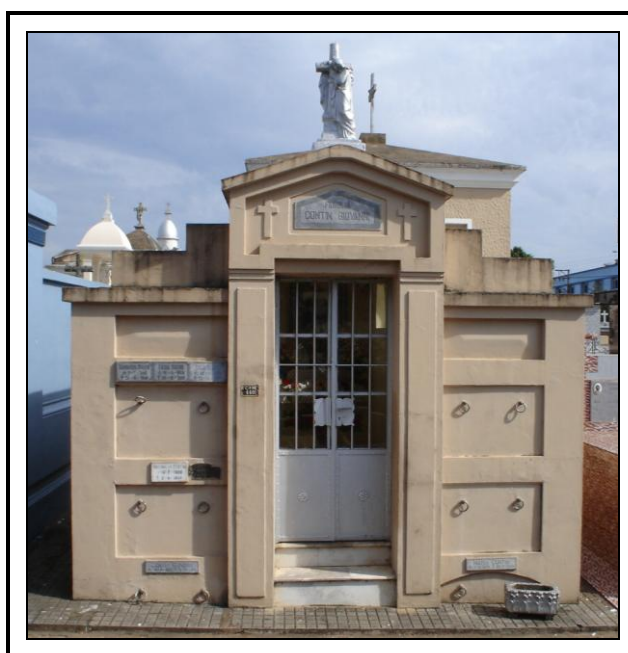
FIGURA 8 – Exemplo de uso de alvenaria no revestimento tumular – Cemitério Municipal São José. Fonte: Acervo pessoal da autora.
