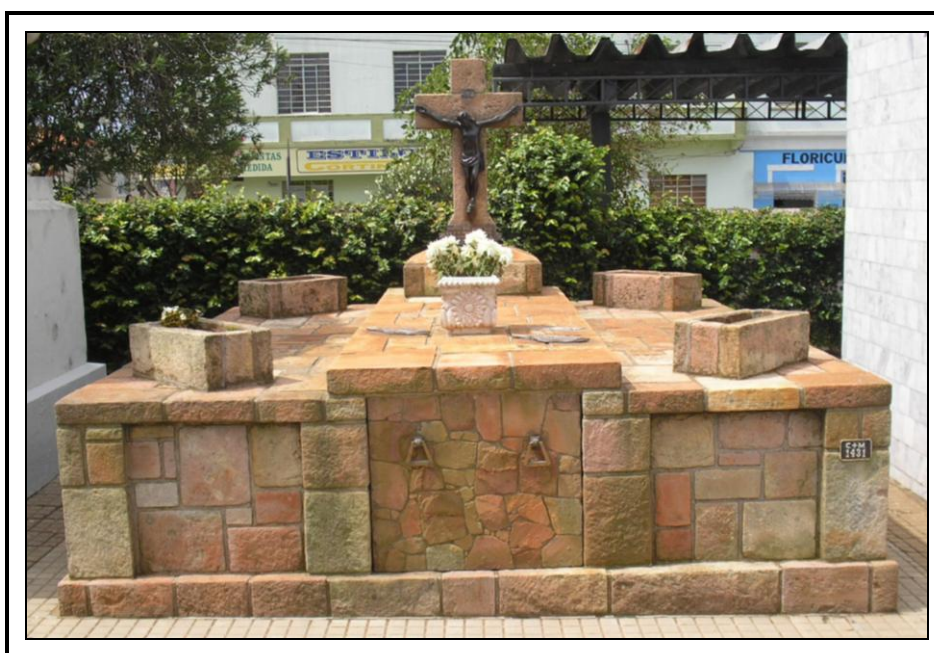
FIGURA 10 – Exemplo de uso de pedra no revestimento tumular – Cemitério Municipal São José. Fonte: Acervo pessoal da autora.
