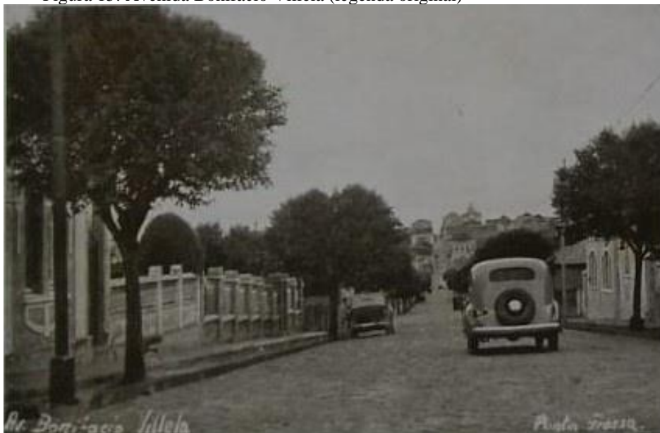
Figura 15: Avenida Bonifácio Villela (legenda original)
