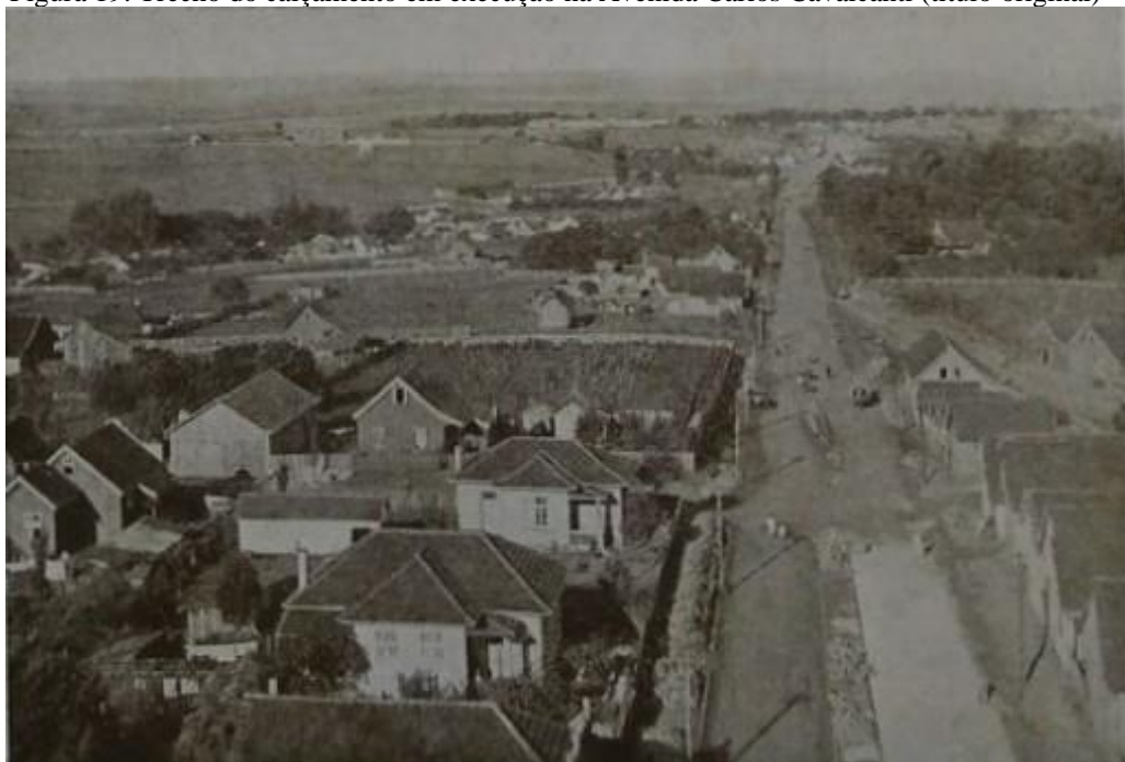
Figura 19: Trecho do calçamento em execução na Avenida Carlos Cavalcanti (título original)
