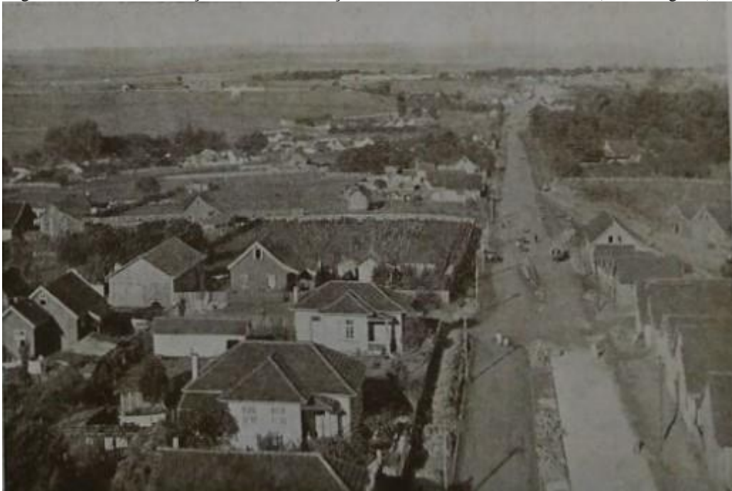
Figura 05: Trecho do calçamento em execução na Avenida Carlos Cavalcanti (título original)
