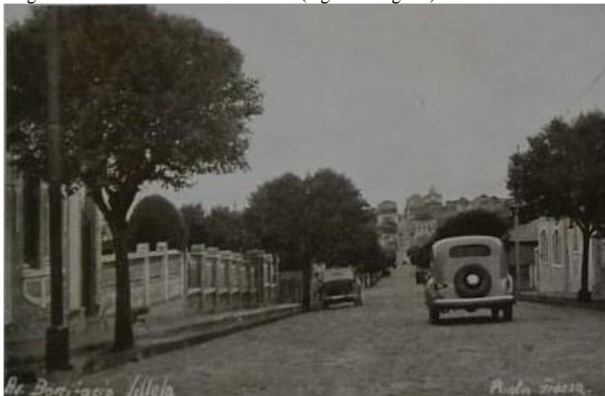
Figura 15: Avenida Bonifácio Villela (legenda original)
