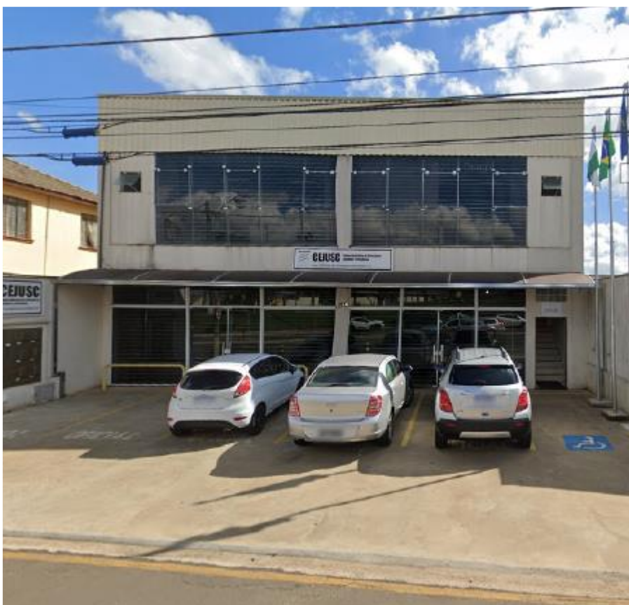
Figura 7 - Prédio do CEJUSC de Ponta Grossa
