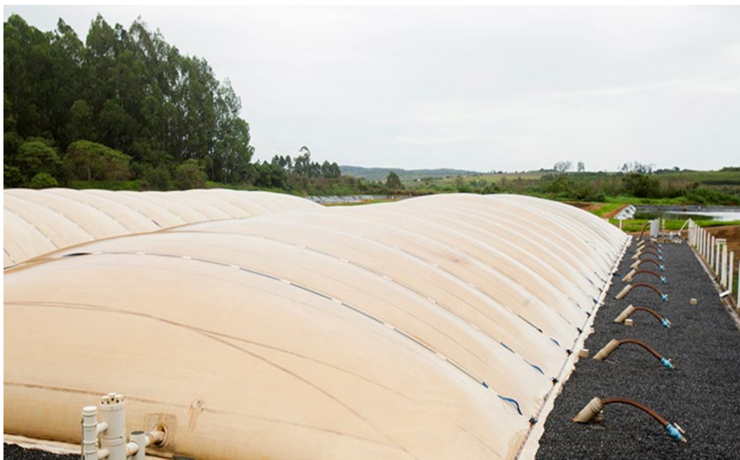
Figura 4 – Representação de um biodigestor modelo canadense, o qual é de fluxo contínuo, horizontal e coberto por uma lona que se infla de acordo com o volume de gás.
