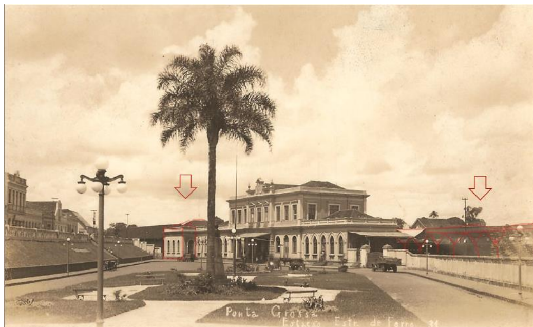
Autor: ND (1931). Acervo: Casa da Memória, 2020, alterada pela autora. Figura 13: Estação Ponta Grossa - gare (2020).
