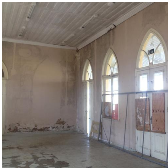
Figura 61 Aparência geral Interna (auditório).
