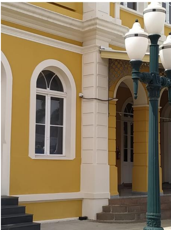
Figura 31: Aparelho à bossagem, mão francesa metálica.
