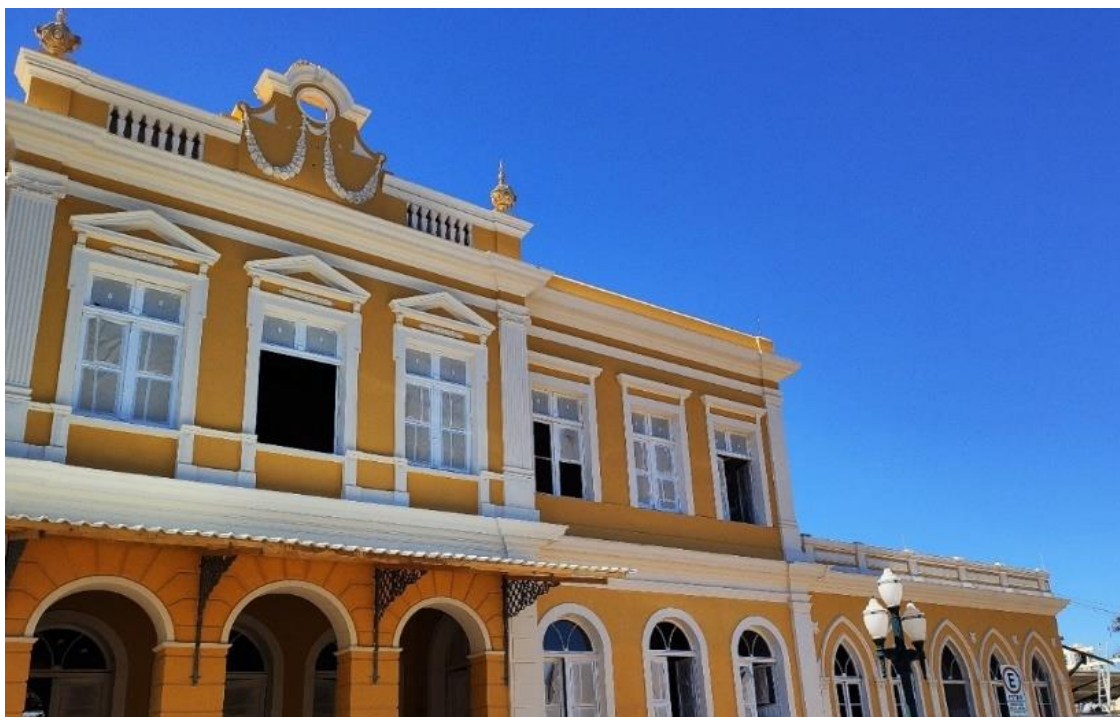
Figura 27: Fotografia vista Fernandes Pinheiro. Platibanda com balaústre, apliques florais e arremate com vasos.
