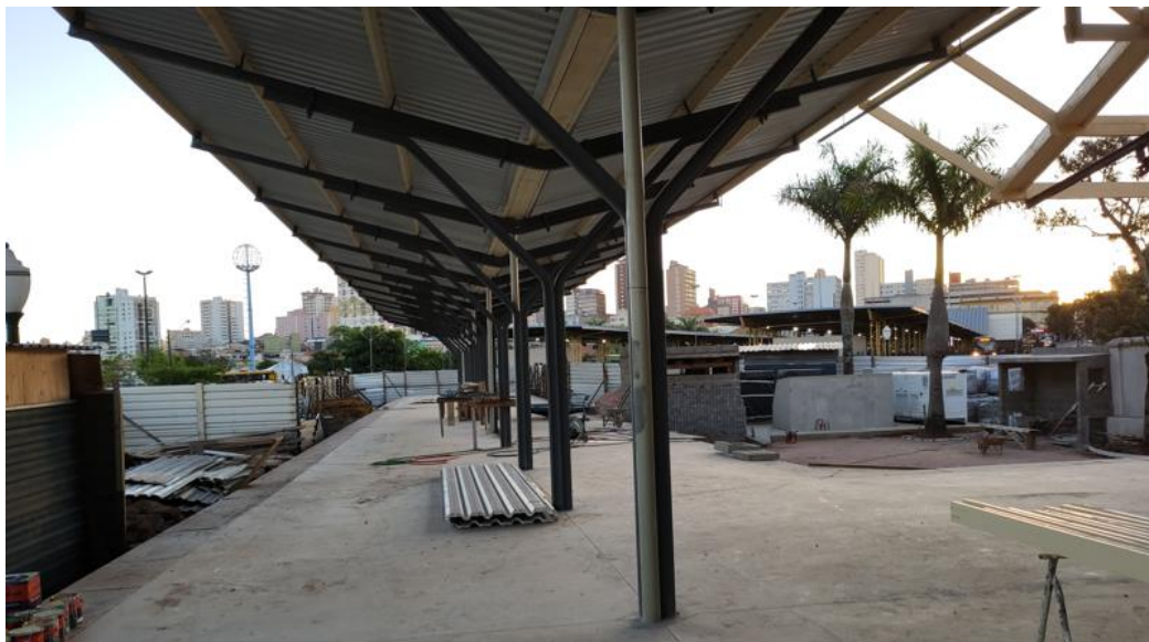
Figura 66: Canteiro de obra, instalação de equipamentos.
