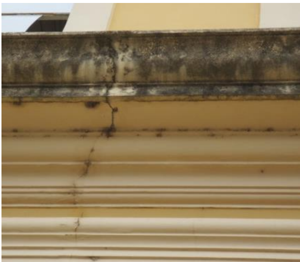
Figura 56: Cimalha com crosta negra
