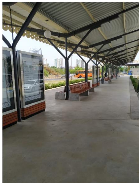
Figura 34: Pilar em V/ cobertura tipo borboleta
