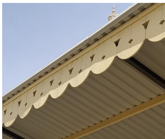
Figura 36: Acabamento beiral em lambrequim.
