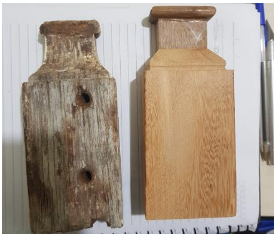
Figura 70: Peça danificada e peça nova da base da janela.
