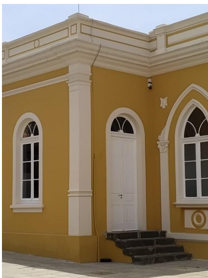
Figura 33: Anexo com janelas arco pleno e platibanda com molduras geométricas em massa.
