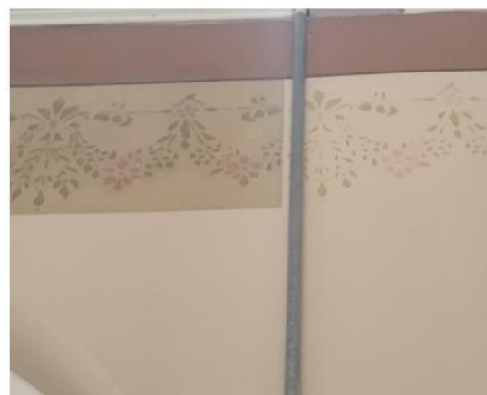
Figura 90: Janela de prospecção da bilheteria.
