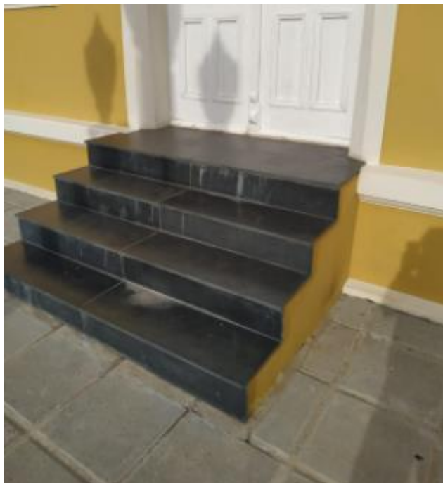
Figura 71: Revestimento escada similar
