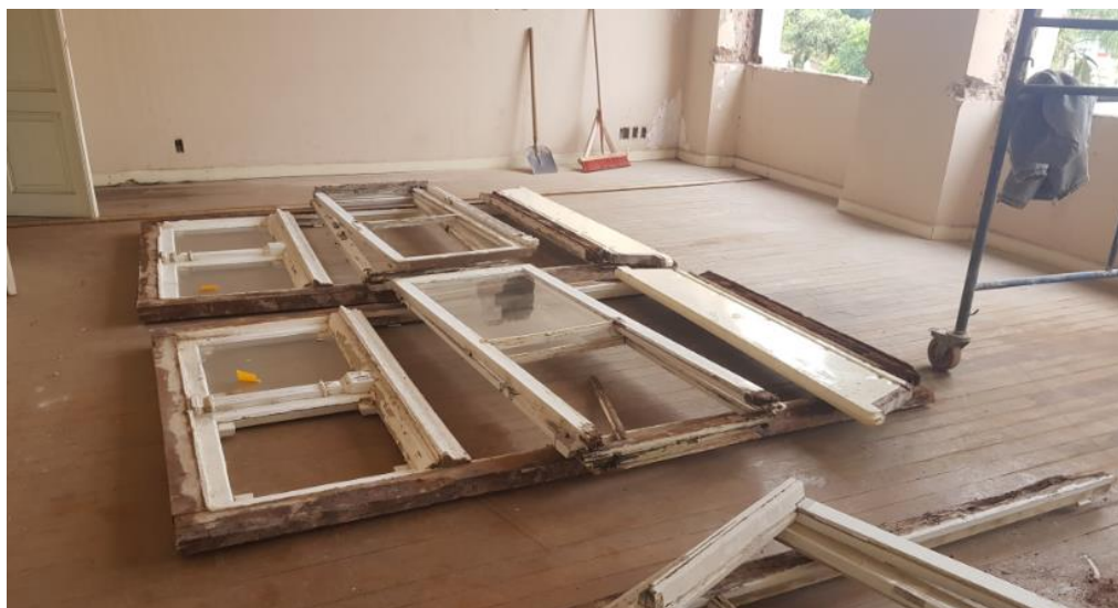
Figura 69: Janelas retiradas dos vãos.
