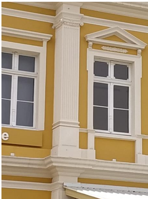
Figura 29: Cunhais com caneluras e janela com verga reta e ornamento encimados de frontão triangular
