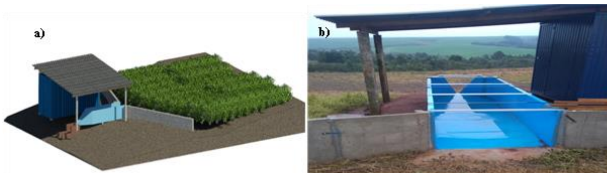
Figura 5 - a) Representação gráfica da unidade de monitoramento do escoamento superficial; b) vista real da calha coletora de escoamento do tipo H com canal de aproximação.
