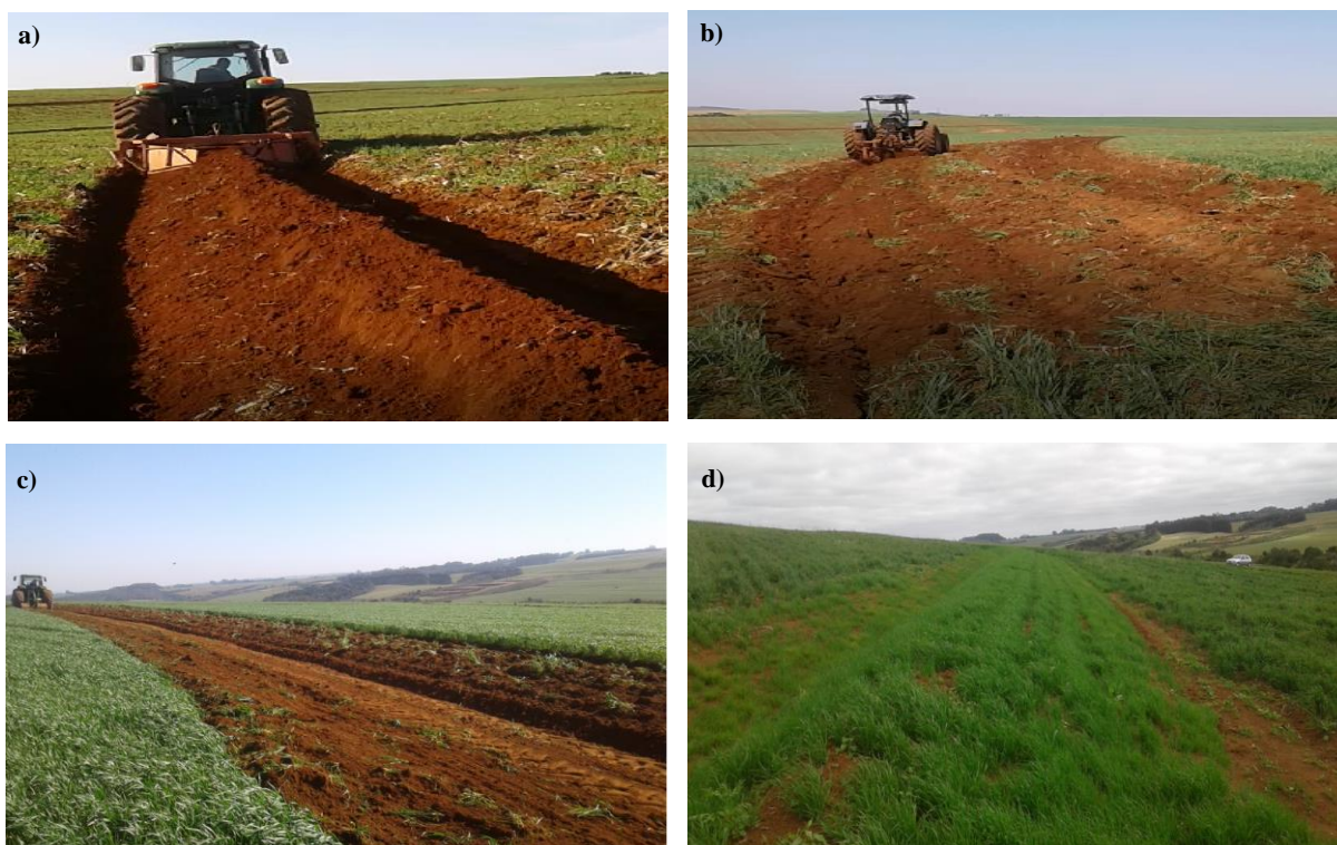
Figura 4 - Etapas da construção dos terraços. a) Construção do dique com terraceador de dois discos. b) Ampliação do dique e abertura do canal com arado de discos. c) Finalização do canal do terraço com lâmina traseira acoplada no trator. d) Semeadura de aveia preta para estabilização do solo nos terraços
