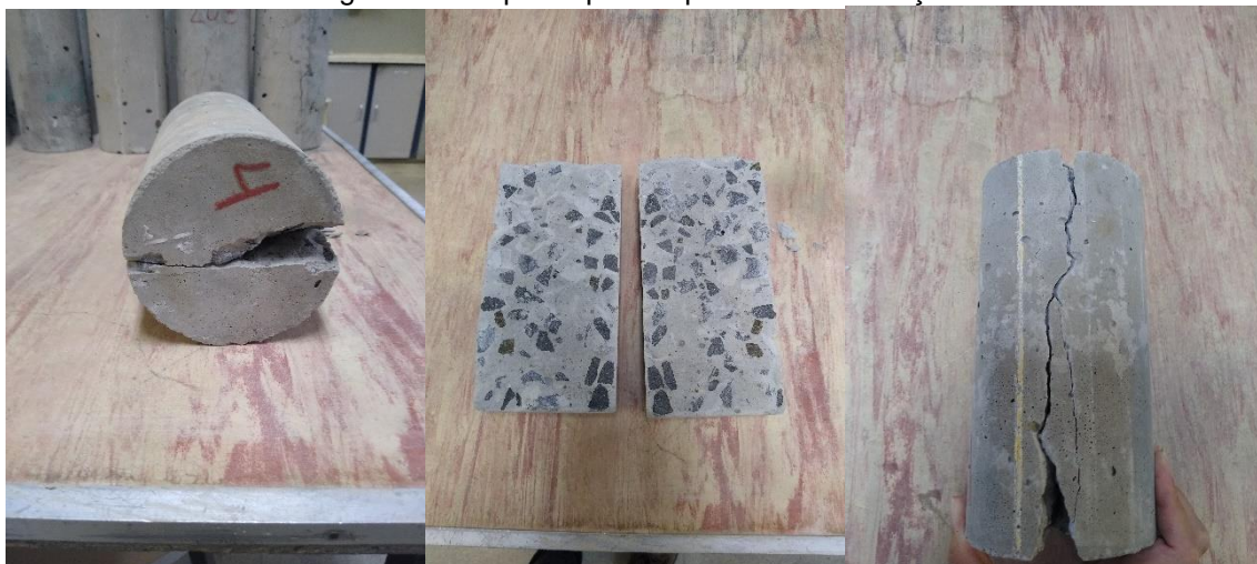
Figura 19: Corpo de prova após ensaio de tração
