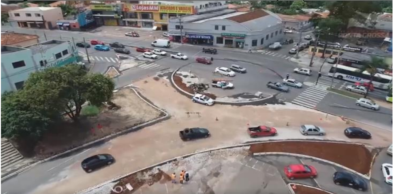
Fotografia 12 - Cruzamento da Avenida Visconde de Taunay em processo de obras.
