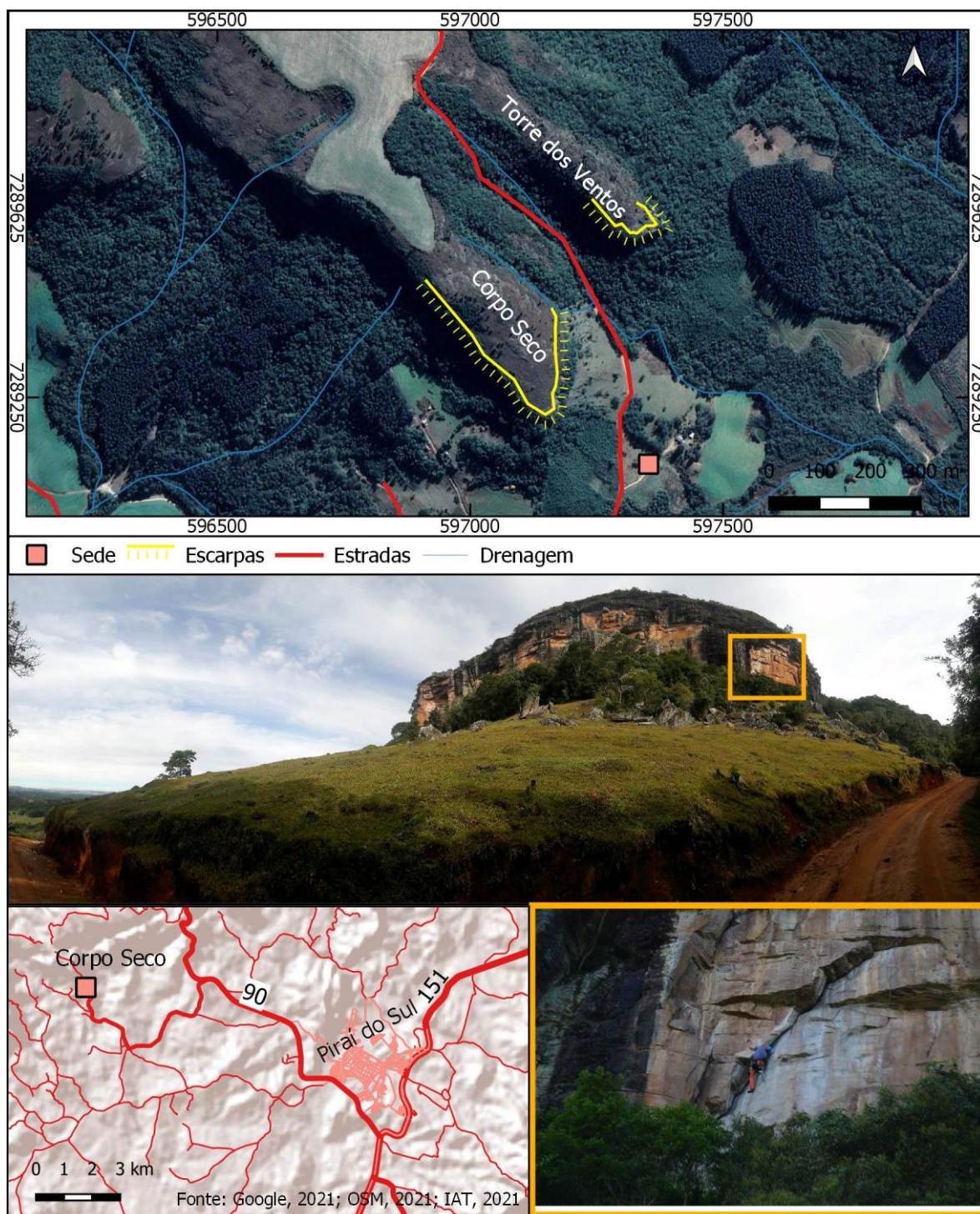
FIGURA 19 – LOCALIZAÇÃO DO SETOR DO CORPO SECO, EM PIRAÍ DO SUL – PR
