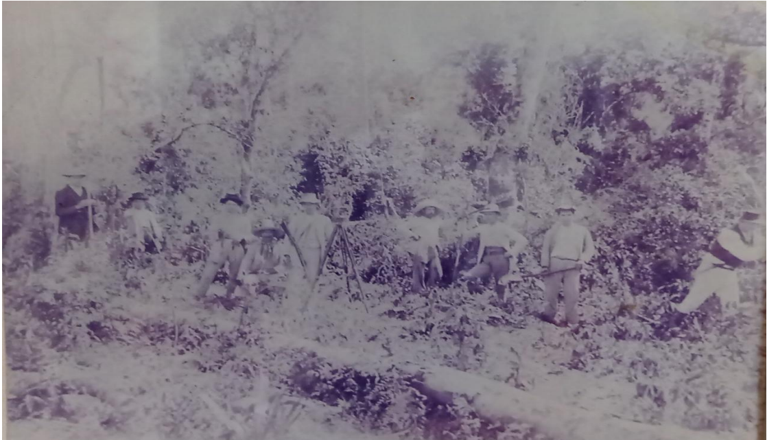
Figura 1 – Colonos nas demarcações dos lotes
