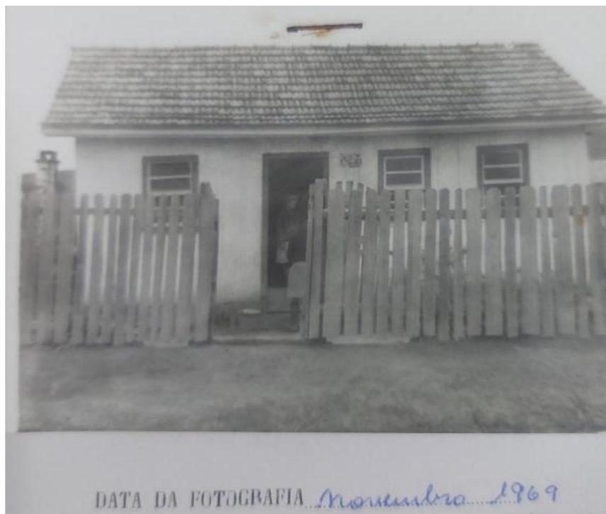
Figura 18 – Fachada da 1ª escola da comunidade
