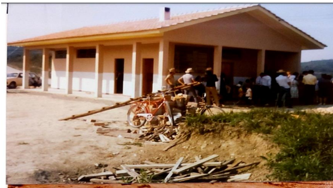
Figura 20 – Fachada da 3ª escola da comunidade
