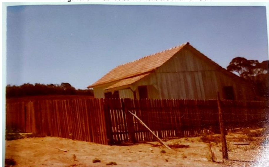
Figura 19 – Fachada da 2ª escola da comunidade
