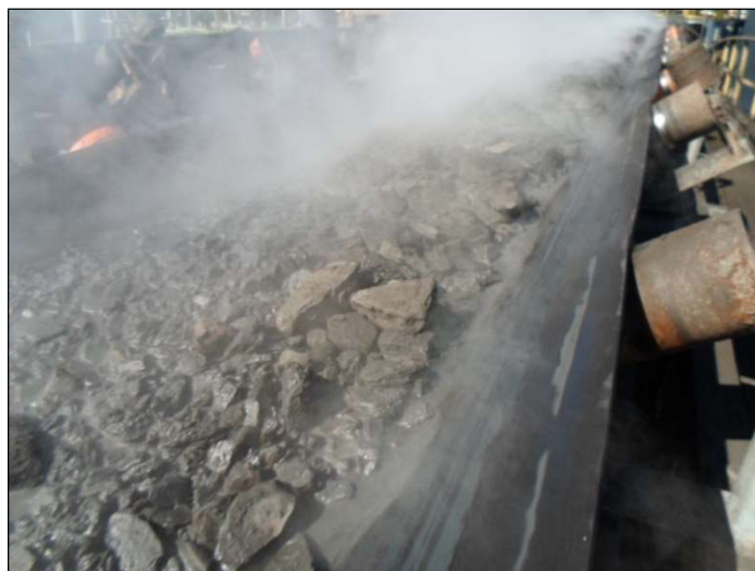
Figura 20 - Transportador de correias jusante (saída) ao vaso de pirólise
