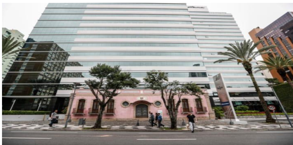
Fotografia 8 – Fachada da antiga residência de David Carneiro com Hotel Pestana ao fundo.
