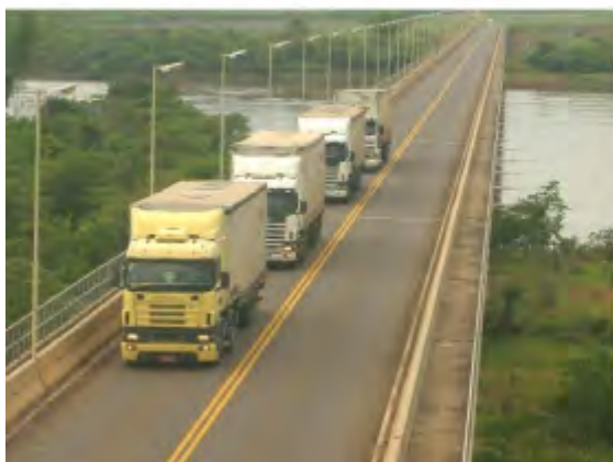
Figura 40 Fluxo de caminhões na ponte. Fonte: Mercovia
