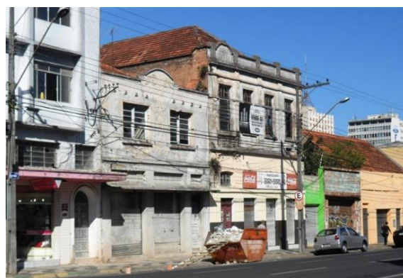
Figura 6 – Prédios históricos subutilizados e degradados - Av. Balduino Taques
