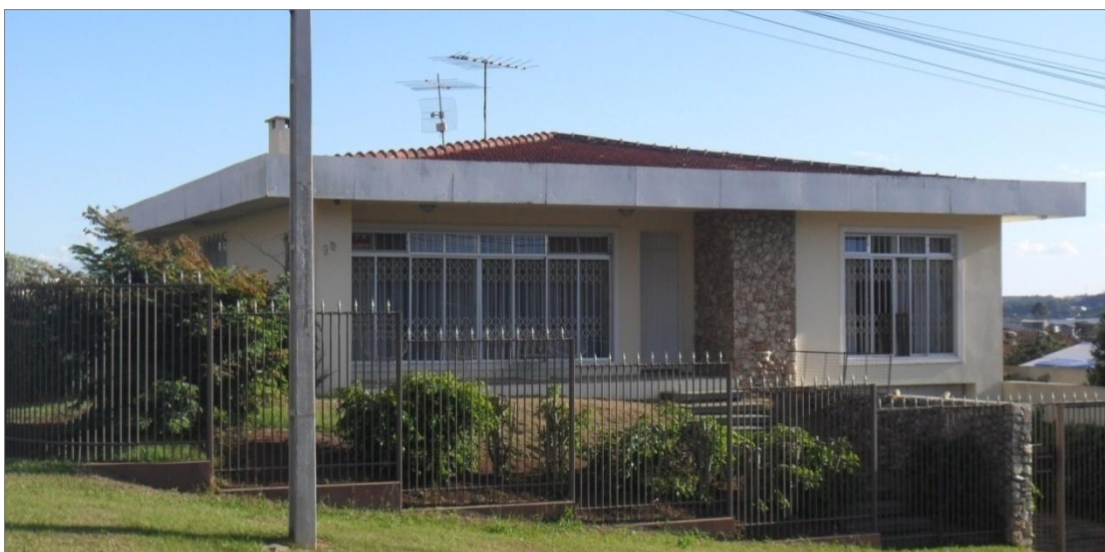
Figura 21 - Residência em estilo modernista projetada para a Família Stroparo - Irati/Pr
