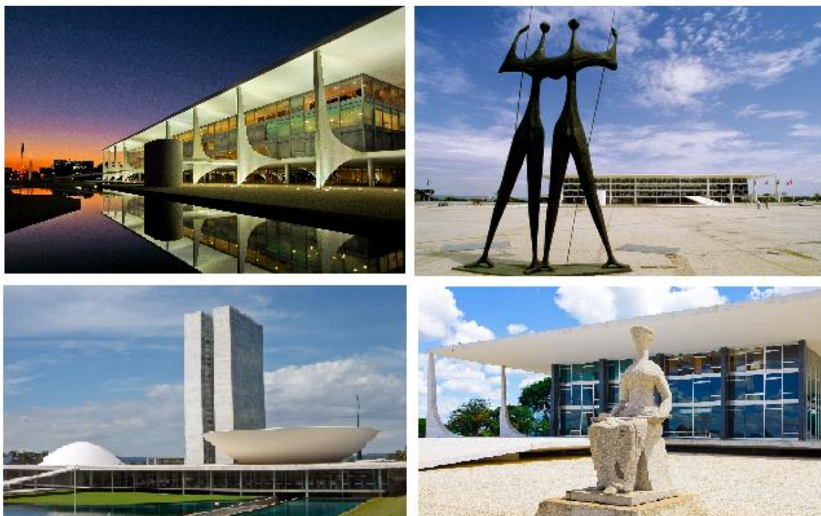
Figura 04 – Construções Modernistas de Niemeyer em Brasília
