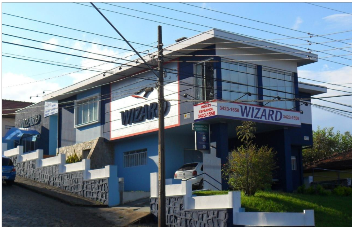
Figura 17 - Residência em estilo modernista projetada para a Família Duszczak - Irati/Pr
