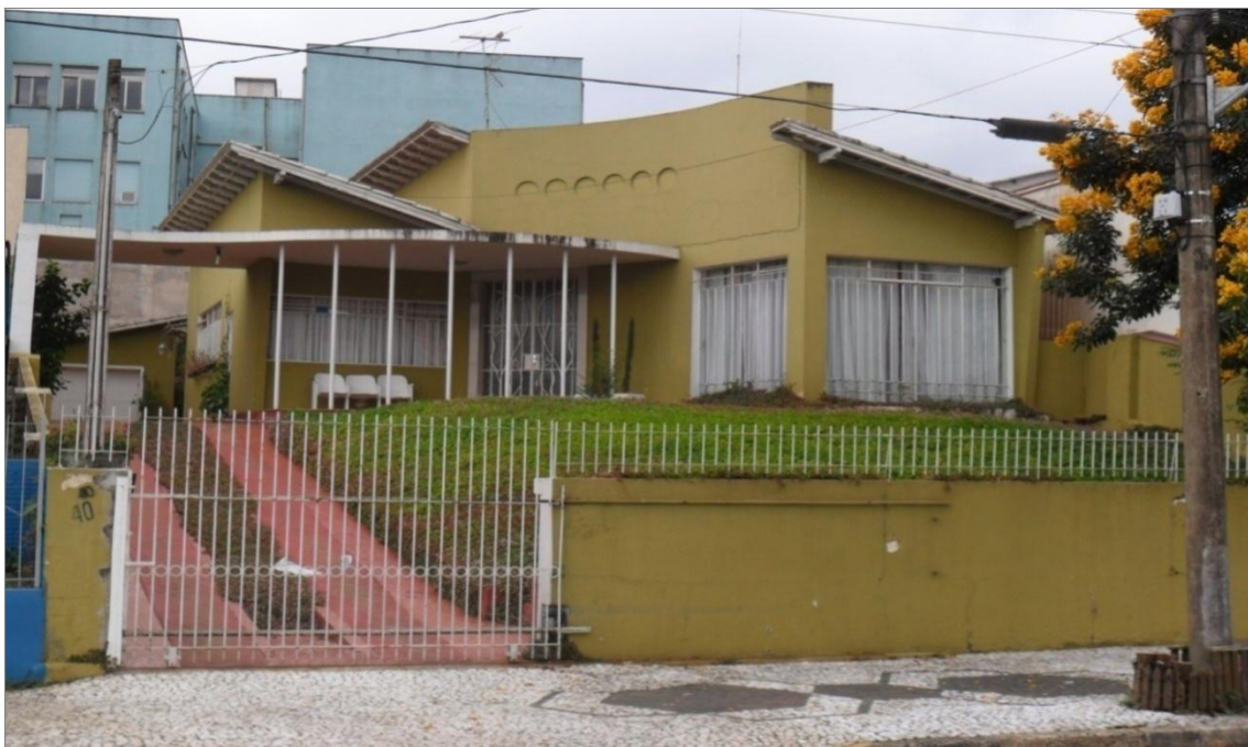
Figura 12 – Residência em estilo modernista projetada para a família Zacarias - Irati/Pr
